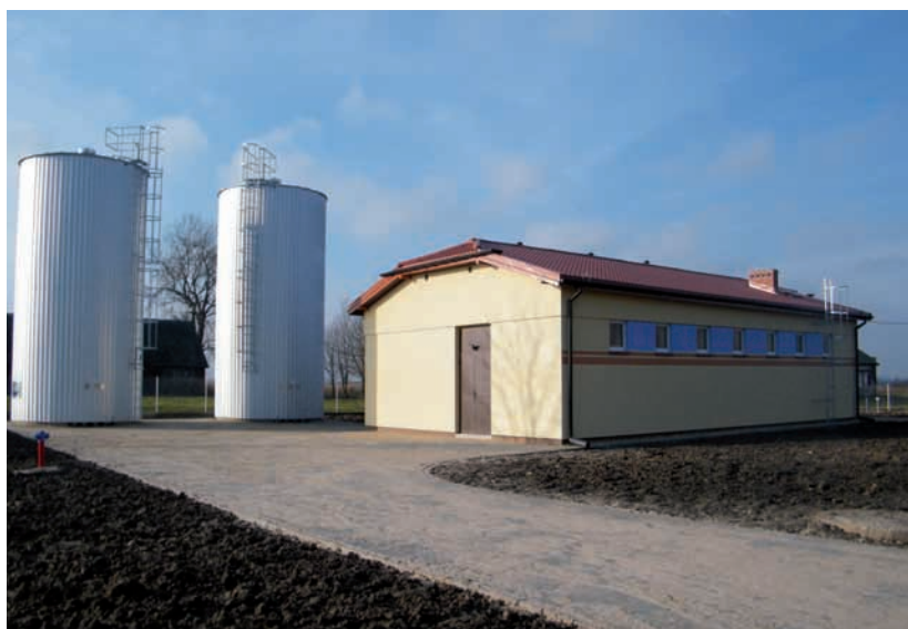
Zmodernizowana Stacja Uzdatniania Wody w Łazowie
