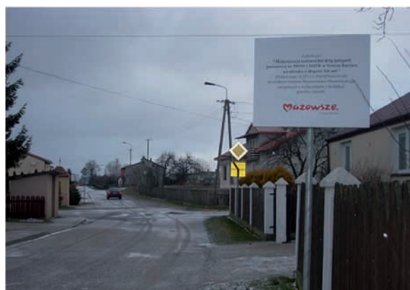
Remont nawierzchni dróg
