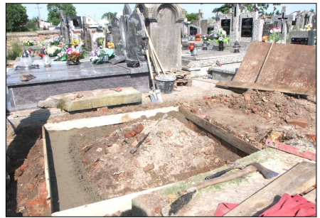
Pomnik w trakcie renowacji (foto z dnia 9 czerwca 2014 r.)
